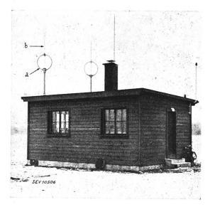
Fig. 8. **Bodenpeilstation** a Rahmenantenne. b Aufgesetzte Vertikalantenne.
