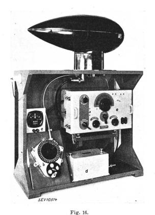
Bordpeilanlage auf dem Prüfstande
