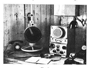
Fig. 9. Innenansicht eines Peilraumes a Peilantrieb. b Peilempfänger. c Taste. d Steuereinheit zu Nahzonensender.
