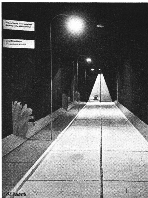
Fig. 11. Ideale Lösung: Strasse beleuchten! Beispiel: mit Natriumdampflampen.
