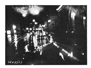
Fig. 5. Limmatquai bei Regen. Schwarze Beläge, gefährliche Spiegelungen. Verwirrung des Autofahrers.
