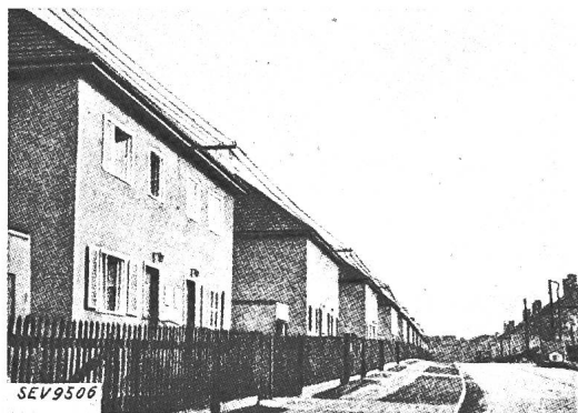
Fig. 2. An Auslegern verlegte Freileitungen.
