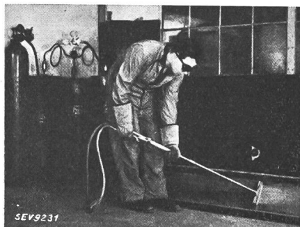
Fig. 4. Décapage au chalumeau.
