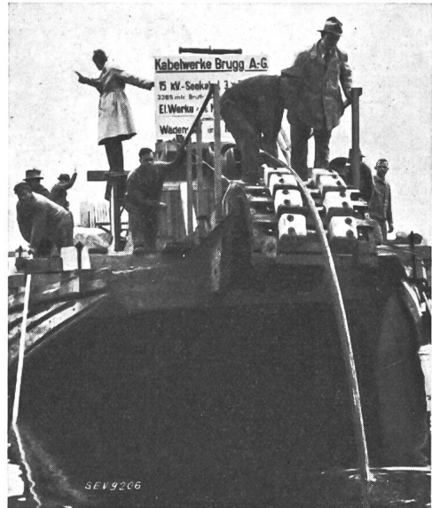
Fig. 9. Verankerung des Kabels in Wädenswil.
