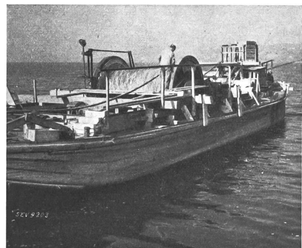
Fig. 6. Aufwickeln des Kabels auf dem Schiff.
