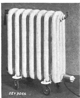
**Description:** Radiateur électrique mobile, selon figure; composé de 7 éléments en porcelaine remplis d'eau. Le corps de chauffe est monté dans la partie inférieure du radiateur. Un interrupteur à bascule fixé à l'appareil, permet de faire fonctionner le radiateur au  $\frac{3}{3}$ ,  $\frac{2}{3}$  et  $\frac{1}{3}$  de la puissance de chauffe. Raccordement au réseau au moyen d'un cordon à gaine de caoutchouc à 3 conducteurs, muni d'une fiche.
