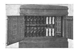
Fig. 12. Verteilkasten mit Steckautomaten.
