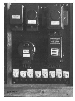
Fig. 4. Einheits-Zählertafel.
