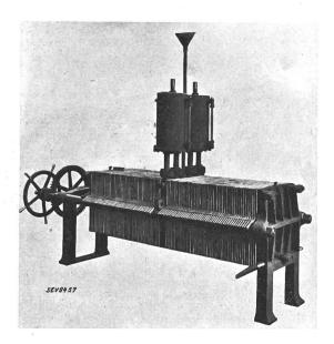
Fig. 6. Electrolyseur système Oerlikon-Schmidt.
