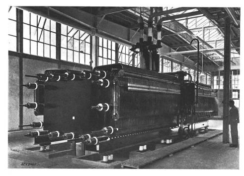
citera tout spécialement le principe des cellules entièrement remplies d'électrolyte et la circulation de l'électrolyte avec séparation des gaz dans deux séparateurs communs à toutes les cellules.
