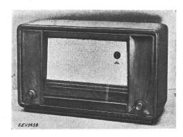
Description: Appareil combiné de radiophonie et de télédiffusion selon figure, pour la réception d'ondes courtes, moyennes et longues, ainsi que pour la télédiffusion à basse fréquence et l'amplification gramophonique. Régulateur de puissance, commutateur parole-musique, régulateur de tonalité combiné avec régulateur de largeur de bande, sélecteur de programme. Prise pour second haut-parleur.
