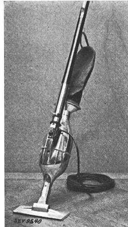
**Description:** Aspirateur électrique de poussière selon figure. Ventilateur à force centrifuge entraîné par un moteur série monophasé, blindé. Le fer du moteur est isolé de la carcasse de l'aspirateur. Manche en bois.
