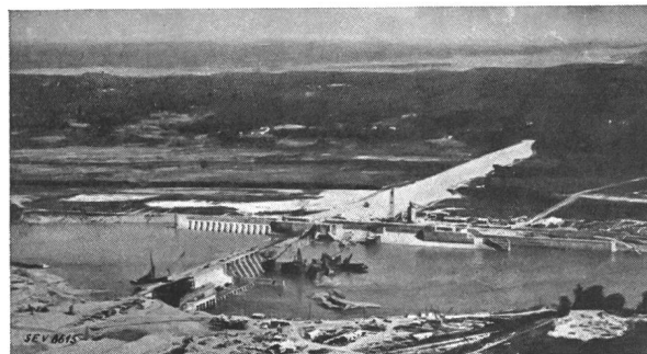
Fig. 5. Pickwick-Landing im Bau.
