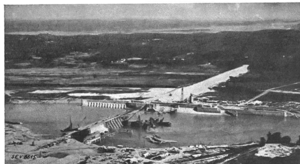
Fig. 5. Pickwick-Landing im Bau.
