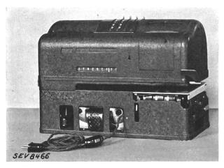
Description: Moteur série monophasé avec régulateur de vitesse, monté dans une machine à affranchir, selon figure. Le régulateur de vitesse, composé d'une résistance et d'un interrupteur à force centrifuge, est disposé entre un des enroulements de champ et le collecteur.
