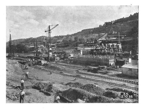
blayé en chantier ouvert sous la protection de batardeaux et de palplanches métalliques, le reste de l'excavation s'étant opéré au moyen de caissons. En ce qui concerne les fondations du bâtiment de l'usine, l'emploi de caissons a été limité à l'exécution de parois destinées à protéger le chantier
