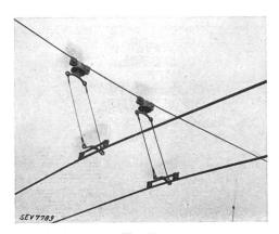
Fig. 10. Suspension normale du fil de contact.
