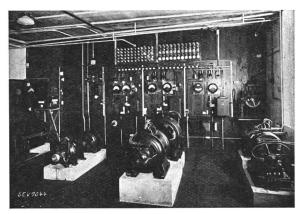
Fig. 2. Centrale à courant continu; trois dynamos entraînées par moteurs biphasés.
