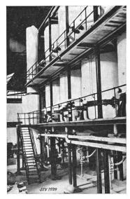
Fig. 2. Verdampferapparate, die mit den Wärmepumpen Fig. 1 betrieben werden.
