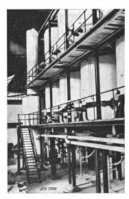
Fig. 2. Verdampferapparate, die mit den Wärmepumpen Fig. 1 betrieben werden.
