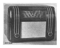
Description: Appareils combinés de radiophonie et de télédiffusion. Modèle 5093 selon figure, modèle 5091 extérieurement très peu différent. Modèle 5093 pour la réception des ondes longues, moyennes et courtes, pour télédiffusion à basse fréquence et pour amplification gramophonique. Modèle 5091 sans ondes courtes ni amplification gramophonique. Régulateur de puissance, régulateur de tonalité et sélecteur de programme. Prise pour second haut-parleur.
