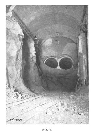
Vue de la partie arrière de la salle des machines. Les deux galeries visibles dans le mur du fond sont les deux citernes à combustible de 3 m de diamètre et de 22,5 m de longueur chacune.
