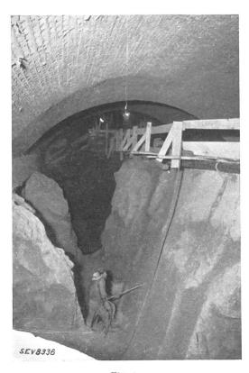
Fig. 1. Démontage de l'échafaudage après l'achèvement de la voûte.
