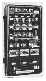
Fig. 1. Ausrüstung einer Drehstromleitung mit Schnell-Distanzschutz.
