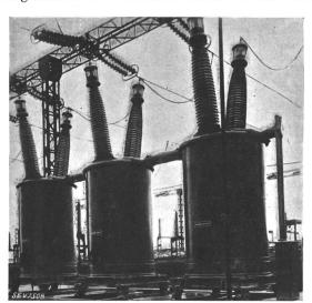
Fig. 1. 220-kV-Kesselölschalter.
