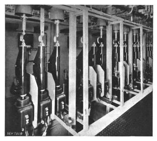
Fig. 2. Schaltanlage mit 11-kV-Wasserschaltern.
