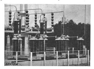
Fig. 3. 220-kV-Konvektorschalter.
