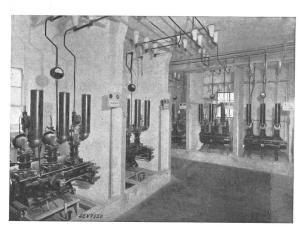
Fig. 43. Modernisierung einer Schaltanlage mit 24-kV-Druckluftschnellschaltern.
