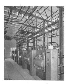
24-kV-Schaltanlage in Hallenbauweise mit Druckluftschnellschaltern.
