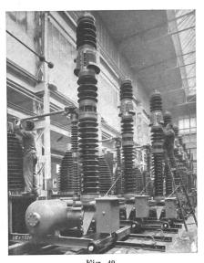
Fig. 49. Montage von 150-kV-Druckluftschnellschaltern für Freiluft.
