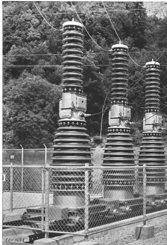
Fig. 9 (oben). Ansicht eines ölarmen Gegenstrom-Schalters, 135 kV, 1500 MVA, mit eingebautem Doppelkern-Stromwandler.
