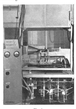
Fig. 9. Braunsche Röhre für Fernsehempfang auf dem Pumpstand. Links: Hochfrequenz-Röhrensender zum Ausheizen der Metallteile. Rechts: Ausheizspule.
