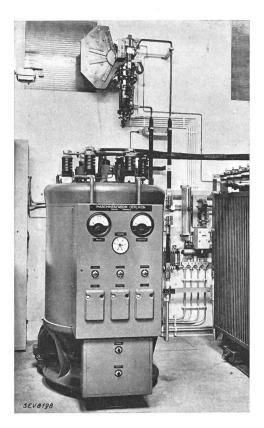
Fig. 8. Luftgekühlter Mutator. 1000 kW, 600 V.
