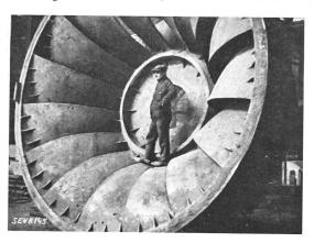
Fig. 4. Laufrad für das Kraftwerk Sungari (unverputzt). (Escher-Wyss.)
