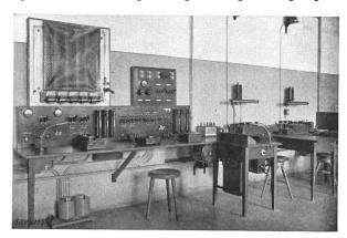
Fig. 14. Station d'étalonnage pour appareils de mesure à courant continu avec compensateur et pont de mesure de résistances.
