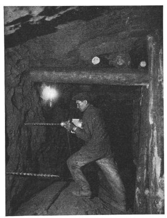
Fig. 16. Bergwerk Herznach: Elektrische Bohrmaschine im Abbau.
