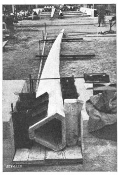
Un dynamomètre est monté dans le dispositif qui reproduit la traction au sommet. On a relevé les efforts de traction qui correspondent aux différentes charges et on a mesuré flexions à divers points le long du poteau.
