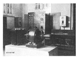
Fig. 17. Einankerumformer mit Transformator und Schalttafel (Brown, Boveri).
