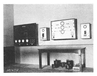
Fig. 16. Arbeitsplatz mit Anschlusstafeln (Siemens). Links Demonstrationstafel für Nullpunktsverlagerung bei Erdschluss. Unter dem Tisch eisenlose Selbstinduktionsspulen (MFO).
