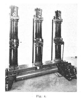
Oelstrahlschalter für Innenraum 60 kV, 759 MVA, Gruppe mit aufgebautem Druckluftantrieb.
