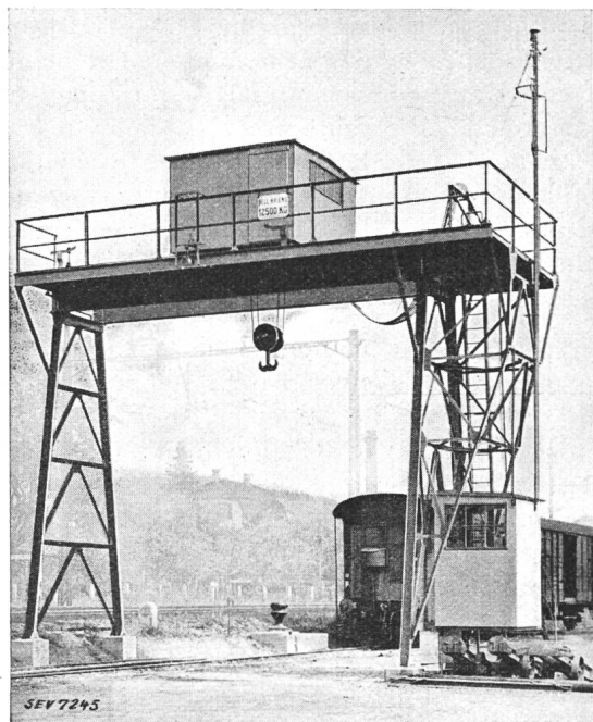
Fig. 5. Grue fixe à chevalet avec cabestan de manœuvre.
