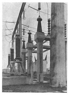
Fig. 6. Unterwerk Saint-Denis, 220 kV. Ankunft der 220-kV-Kabel. Links Kaskadenspannungswandler, in der Mitte die Kabelendverschlüsse, auf Betonstützen montiert. In den beiden äussern Phasen Kondensatoren für die Hochfrequenztelephonie.
