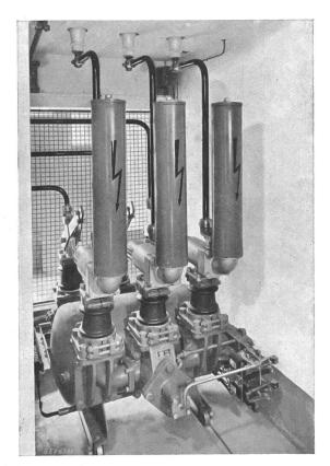
Fig. 4. Schalterzelle mit Brown-Boveri-Schalter.
