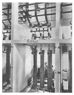
Fig. 6. Schalterzelle mit MFO-Schalter.
