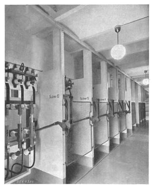
Fig. 7. Zellenreihe mit Sprecher & Schuh-Lasttrennern.
