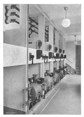
Fig. 5. Zellenreihe mit MFO-Schaltern.
