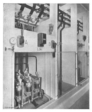
Fig. 3. Zellenreihe mit eingebauten Brown-Boveri-Schaltern.
