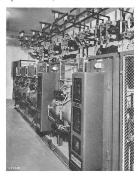
Fig. 9. Montage des relais de distance Brown Boveri.
