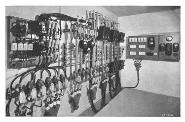
Fig. 6. Installation basse tension avec interrupteur pour réseau maillé et disjoncteurs automatiques à fiches.
