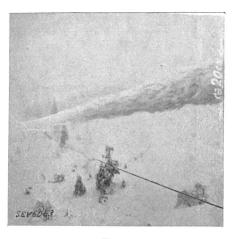
Fig. 7. Le fil de terre chargé de givre entre les pylônes 123 et 124. 7-III-36, à 16 h env.
