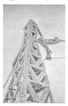
Fig. 4 Pylône 121 b recouvert de givre, le 7-III-36, à 13 h env.
