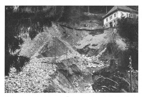
Fig. 1. Erosions profondes de plusieurs mètres devant le bâtiment des appareils.
