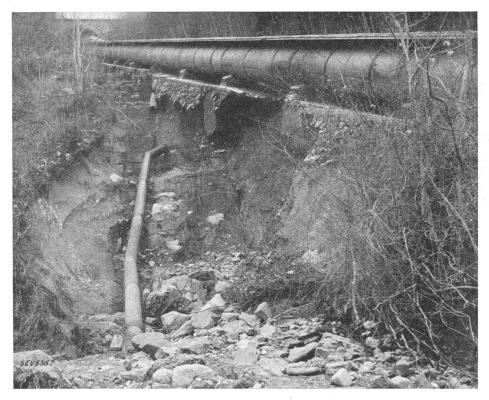
Fig. 3. Erosions dans le tracé des conduites forcées. Conduite de vidange avariée.
