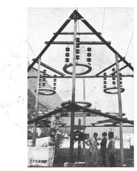
Fig. 8. Poste de klydonographes pour 150 kV à Bodio.
