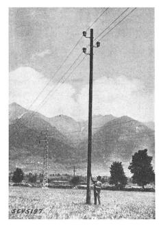
Fig. 18. Vue de l'éclatement du poteau 27, distant de 400 m environ d'un pylône en fer mis à la terre de la même ligne.
