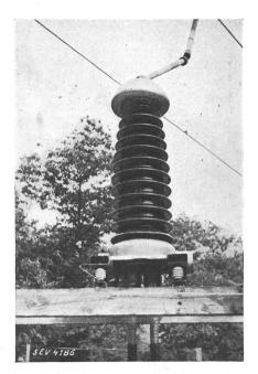
Fig. 6. Vue d'une boîte d'extrémité de câble à 150 kV à Lavorgo, avec résistance de mannite raccordée (en haut).
