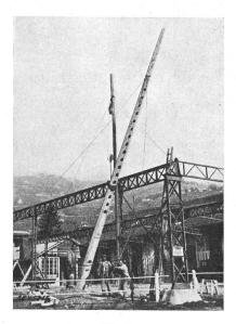
Fig. 3. Erection d'un poteau.
