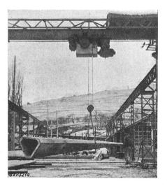
Fig. 2. Le poteau peut être soulevé par un seul câble placé au centre de gravité, sans subir de déformation appréciable.
