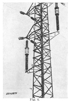
Couplage bifilaire sur une ligne de 60 kV.
