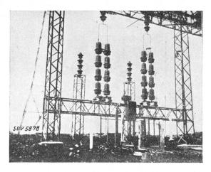
$\label{eq:Fig.5.} {\rm Couplage\ bifilaire\ sur\ une\ ligne\ de\ 150\ kV}.$
