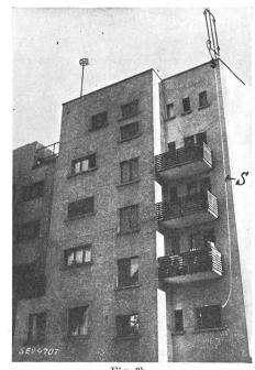
Fig. 3b. Bâtiment où les mesures B ont été effectuées. S Câble à écran (Silberantenne).
