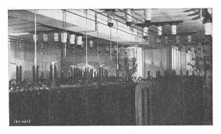
$\begin{array}{c} {\rm Fig.\,1.} \\ 3000\text{-kVA-Phasenschieber-Kondensatorenanlage} \\ {\rm im} \ \ 50/10\text{-kV-Unterwerk} \ \ {\rm Auma.} \end{array}$
