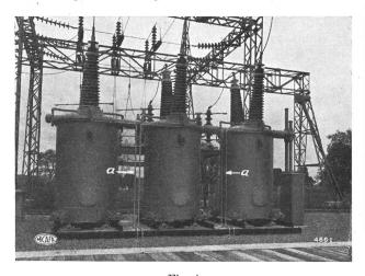
Fig. 4. 150-kV-Oelschalter im U.-W. Rathausen mit den Anschlüssen a für das Synchronoskop Fig. 5.
