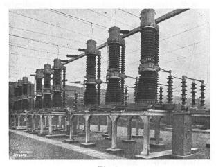
Fig. 9. Schaltanlage Chèvres des E. W. Genf mit 135-kV-Konvektorschaltern.
