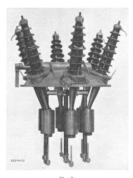
Fig. 7. Dreipoliger Oelschalter für 87 kV, mit Konvektoren. Abschaltleistung 750 MVA. Aktiver Teil des Schalters ohne Oelkessel.
