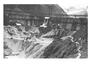
Fig. 12. (Phot. Briffod) Staumauer, Luftseite, mit Betonaufbereitungsanlagen.
