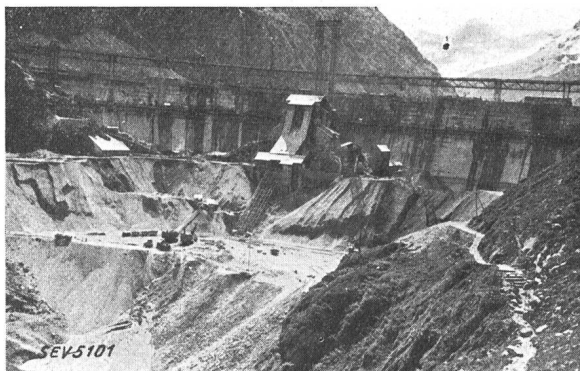
Fig. 12. (Phot. Briffod) Staumauer, Luftseite, mit Betonaufbereitungsanlagen.
