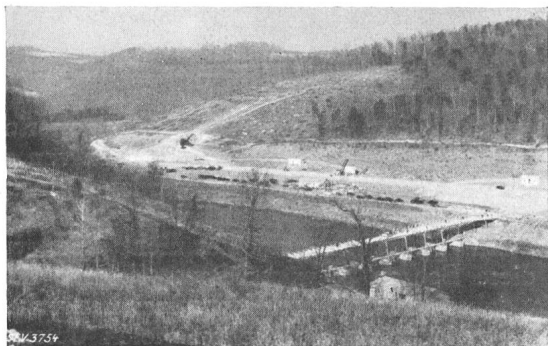
Fig. 5. Baustelle des Norrisdammes, Blick flussaufwärts. Die abgeholzte Stelle in der Mitte des Bildes wird das östliche Widerlager des Dammes aufnehmen. Die Axe des Dammes liegt etwa an der Stelle des Schürfbaggers. Im Vordergrund Dienstbrücke für den Bau. Stand der Arbeiten am 2. Dezember 1933.
