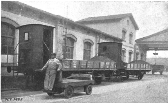
Fig. 6. Elektrokarren beim Ziehen von Eisenbahnwagen.
