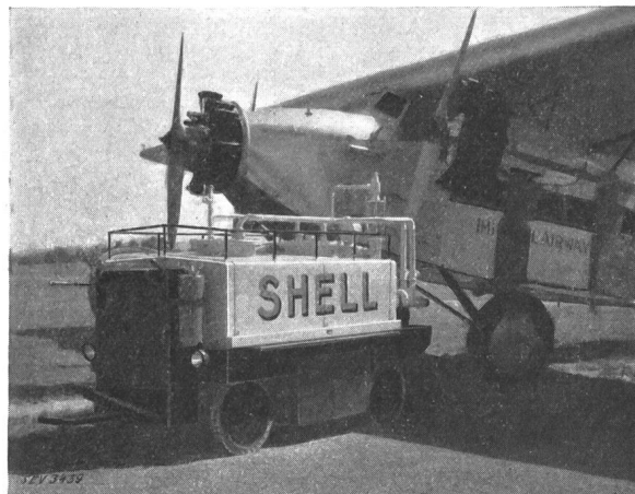
Fig. 13. Elektrotankkarren auf dem Flugplatz.
