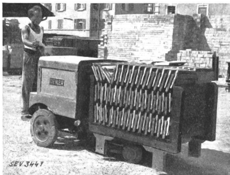
Fig. 7. Hubkarren beim Ziegeltransport, 1½ t.
