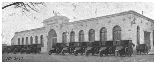
Fig. 1. Gruppe ablieferungsreifer Dreiradwagen für die Postverwaltung (Paketbestelldienst). Ladegewicht 300 kg.
