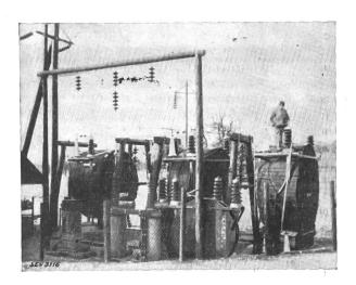
Fig. 2. Vue du générateur de chocs à cables.
