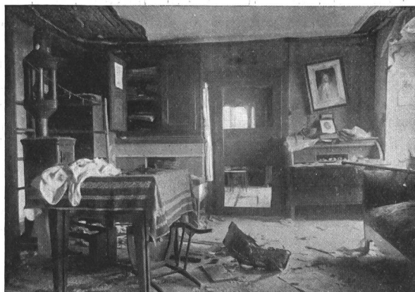
Fig. 15. Cas 131—32, Montenol, intérieur d'une des pièces les plus fortement dévastées.
